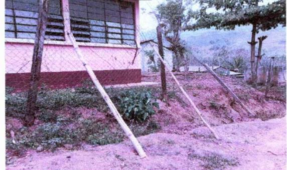
Foto 2: Se observa desprendimiento de los postes de madera que pueden ocasionar un peligro.
