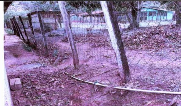
Foto 6: Se observa desprendimiento de malla en la parte trasera del modulo 1
